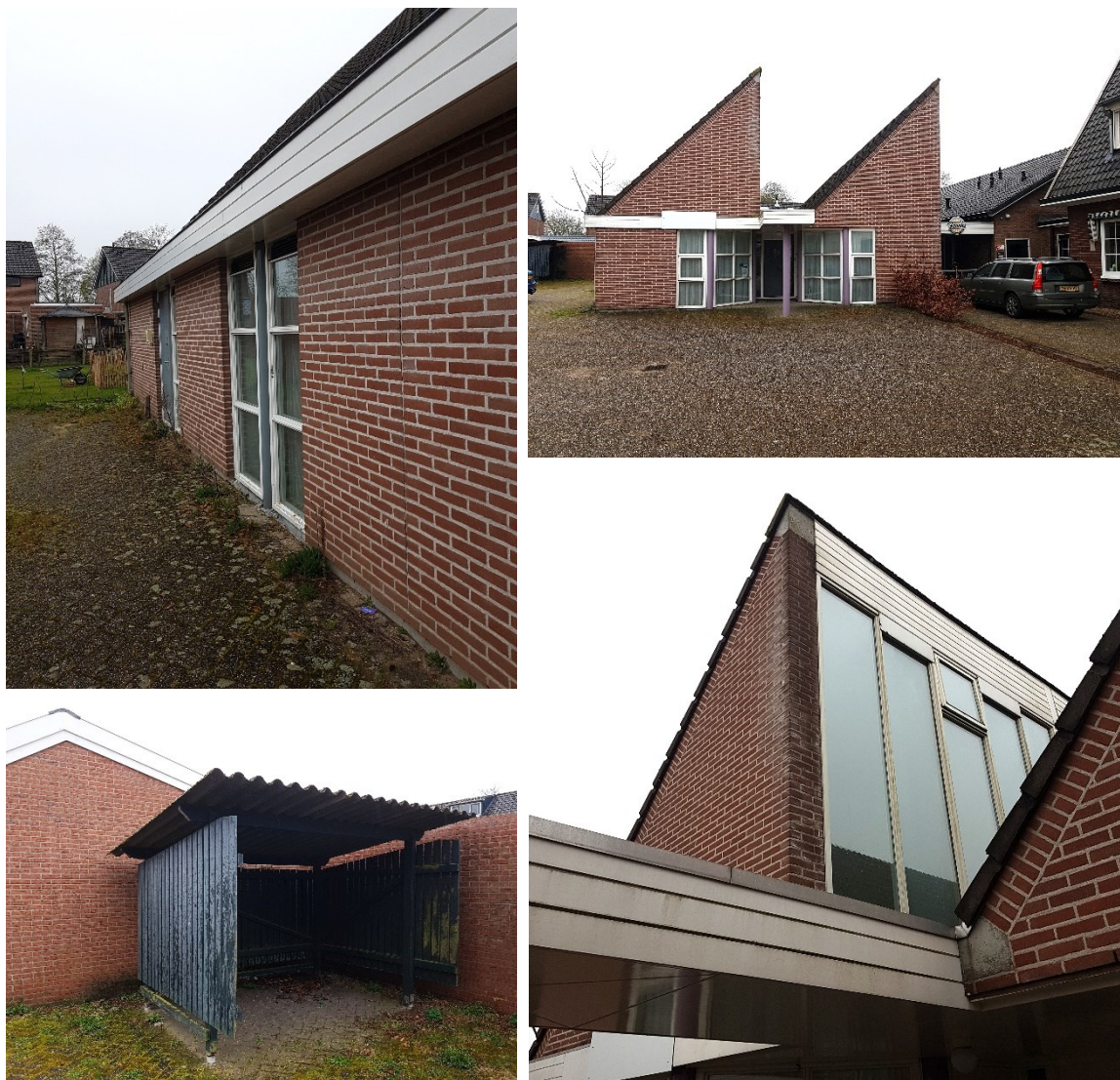
Figuur 2. Zijgevel van het gebouw (linksboven), vooraanzicht van het gebouw, waarbij de zaagtandvorm goed zichtbaar is (rechtsboven), kleine fietsenstalling (linksonder) en de binnengevel van het gebouw met grote ramen (rechtsonder).
