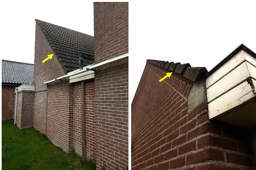
Figuur 5: Voorbeelden van potentiële verblijfplaatsen van gebouwbewonende vleermuizen in openingen onder kantpannen van de bebouwing.
