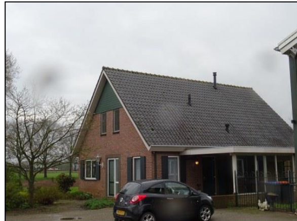
Figuur 13. Overdekt dakdeel met kantpannen.
