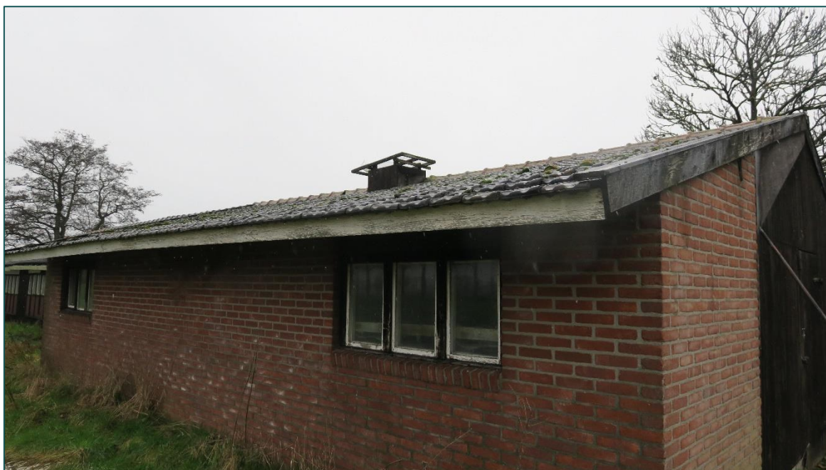
Figuur 1 Schuur A op de planlocatie wordt gesloopt.
