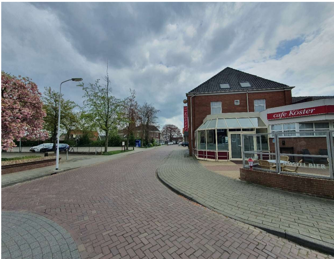
Figuur 3: Plangebied aan de Dorpsstraat 26 in Etten, gezien vanuit het westen. Foto: B. Smeets | Ecoresult B.V.
