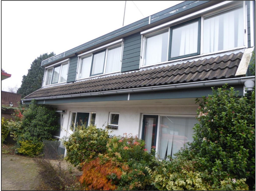
De dakpannen bij het kantoorgebouw.
