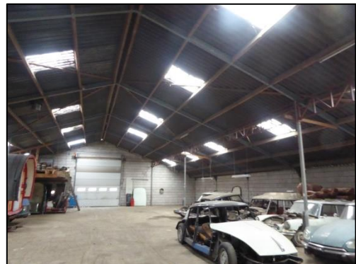
De binnenkant van de zuidelijke loods.
