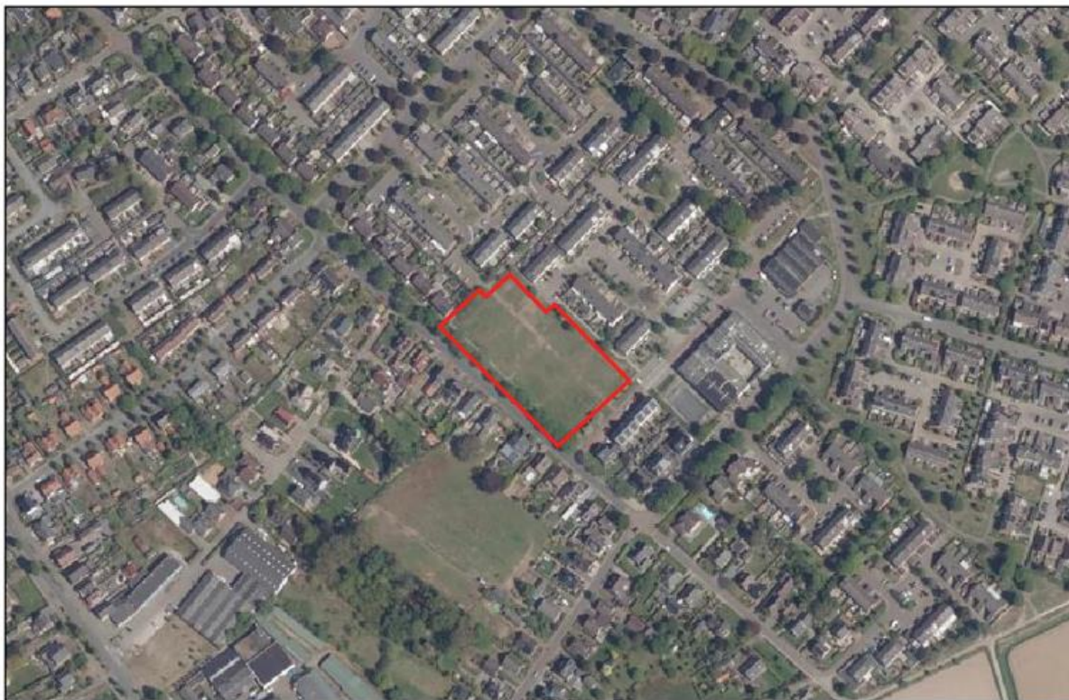
Afbeelding 2.1 Luchtfoto huidige situatie plangebied (Bron: PDOK)
