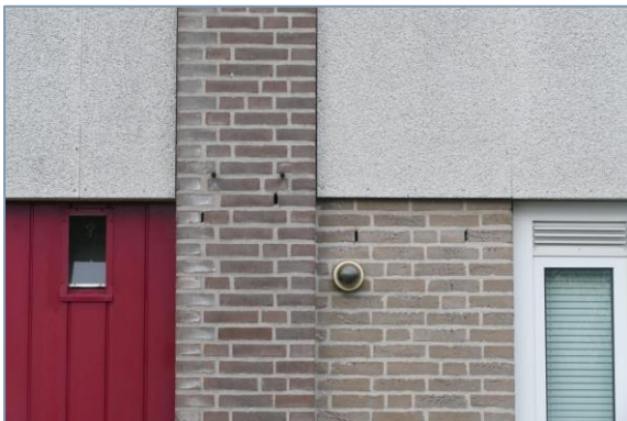
Foto 5. Open stootvoegen: geschikt voor vleermuizen.
