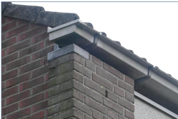
Foto 7. Open stootvoegen en ruimte tussen muur en dakgoot: geschikt voor vleermuizen en gierzwaluw.
