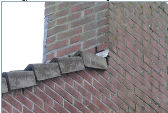
Foto 8. Kieren onder dakpannen en bij schoorsteen: geschikte in- en uitvliegplek voor vleermuizen en gierzwaluw.
