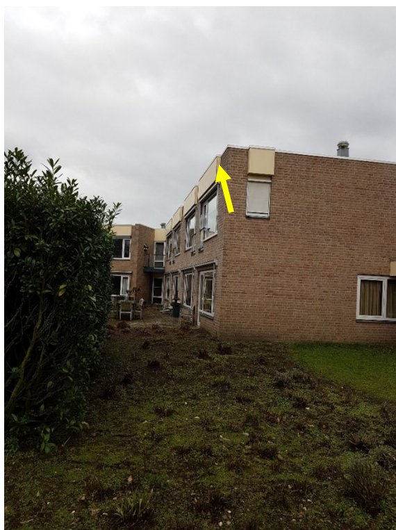
Figuur 3. Locatie waar een gewone dwergvleermuis uitvloog tijdens het veldbezoek van 7 juni 2022 langs de randen van het overstek (gele pijl). Deze verblijfplaats bevindt zich aan de oostzijde van het grote gebouw.
