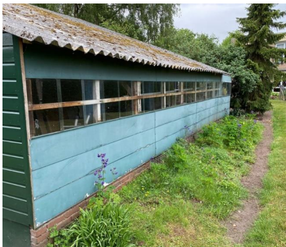
Foto 1: noordzijde schuur, druppelzone
