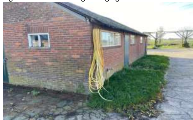
Figuur 20: onverharde afwateringzone
