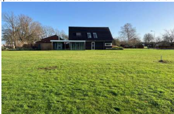
Figuur 12: Overzichtsfoto onderzoekslocatie
