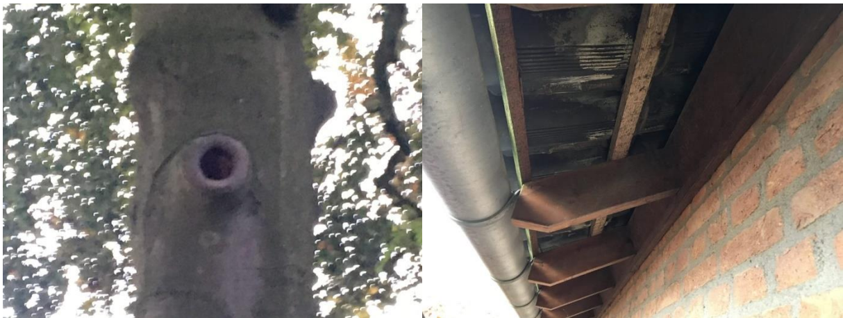
Foto links; De hopen in sommige beuken vormen potentiële invliegopeningen voor vleermuizen. Foto rechts; De betimmering van het dakoverstek van de paardenstal sluit naadloos aan op de buitengevels.
