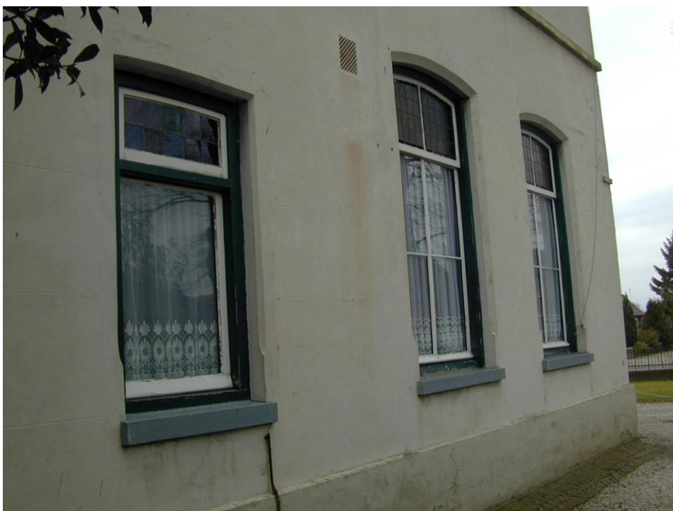
Pastorie; gedeelte van de linker zijgevel, ter plaatse van de begane grond.
