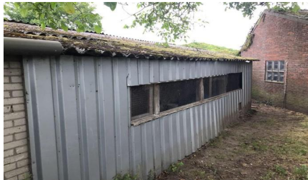
Figuur 15: Druppelzone met verdachte golfplaten
