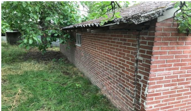
Figuur 14: Druppelzone met verdachte golfplaten
