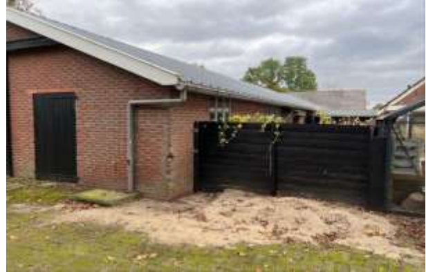
Figuur 16: Dakgoot bebouwing
