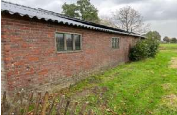
Figuur 15: Aanwezige druppelzone loods
