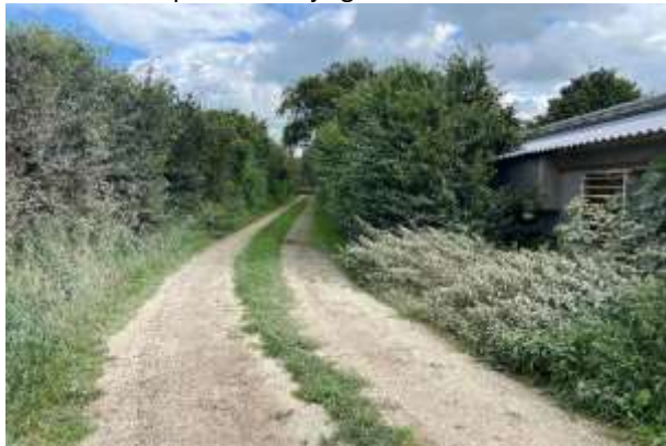
Figuur 13: Aanwezige puinverharding
