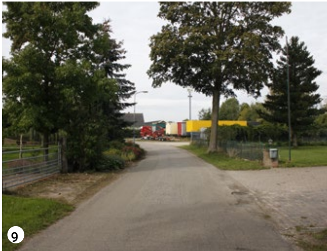
Zicht vanaf de Geurinkstraat ri. noordwest
