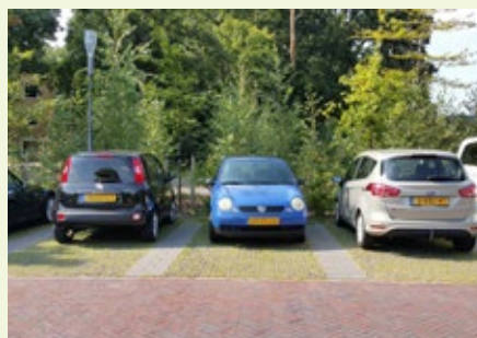
Parkeren op grasbetonstenen
