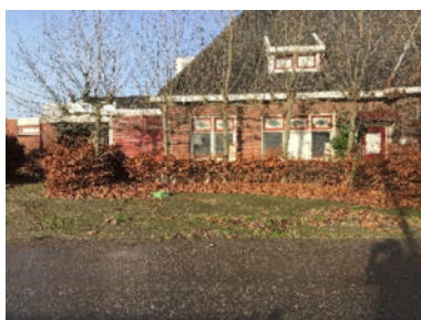
foto 1 - ingang voorzijde - klinkerverharding
