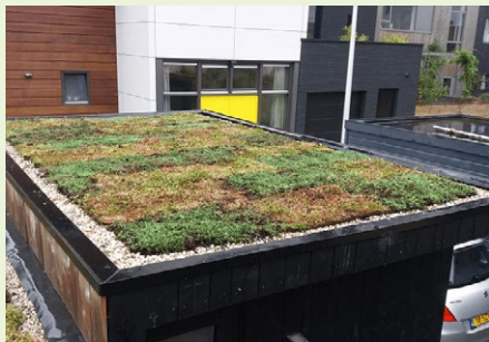
Bijgebouwen met sedumdak
