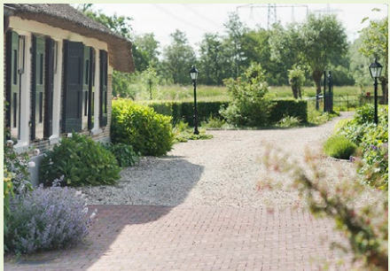
Halfverharding voor oprit
