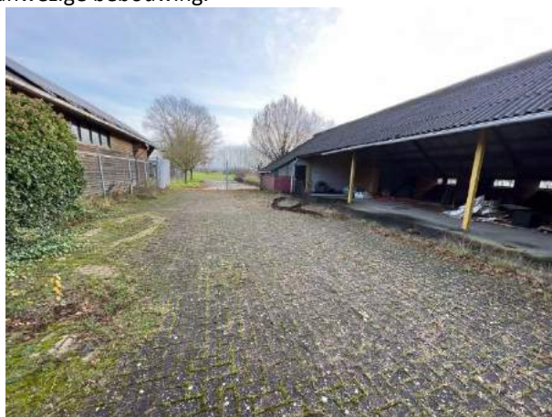
Figuur 12: Dak(goot) bebouwing
