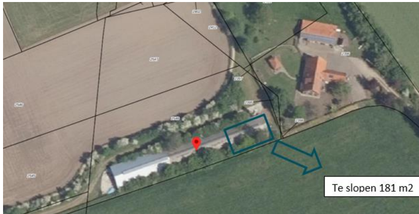
Figuur 7: foto van de te amoveren met marker aangeduide pluimveestal aan de Sinderenseweg 74 in Sinderen en te slopen 181 m 2 . Er wordt aan de lokale kwaliteitscriteria voor het toepassen van de regeling voor functieverandering en hergebruik vrijkomende agrarische bebouwing voldaan omdat:
