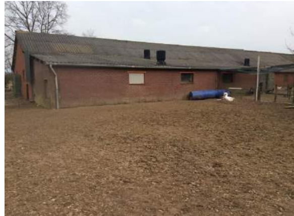
Figuur 15: Overzichtsfoto bebouwing
