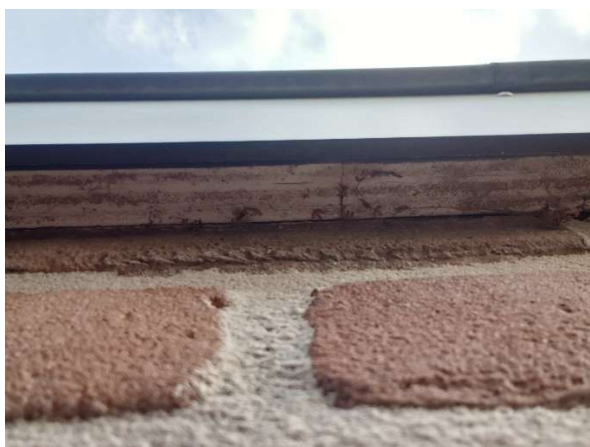
Foto 7: Overgang muur - dak gebouw
