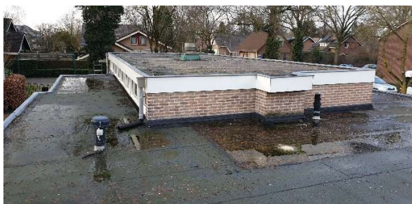
Foto 5: Dak van hoog deel en van achterzijde gebouw
