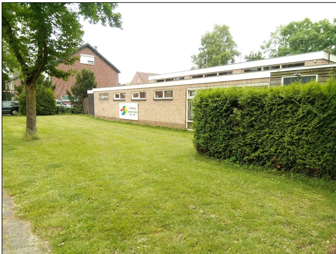
Afbeelding 13: Overzicht van de noordzijde van het plangebied. Foto in zuidoostelijke richting
