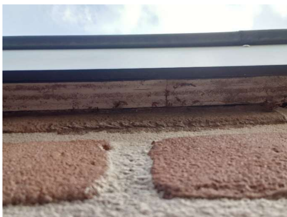
Foto 7: Overgang muur - dak gebouw
