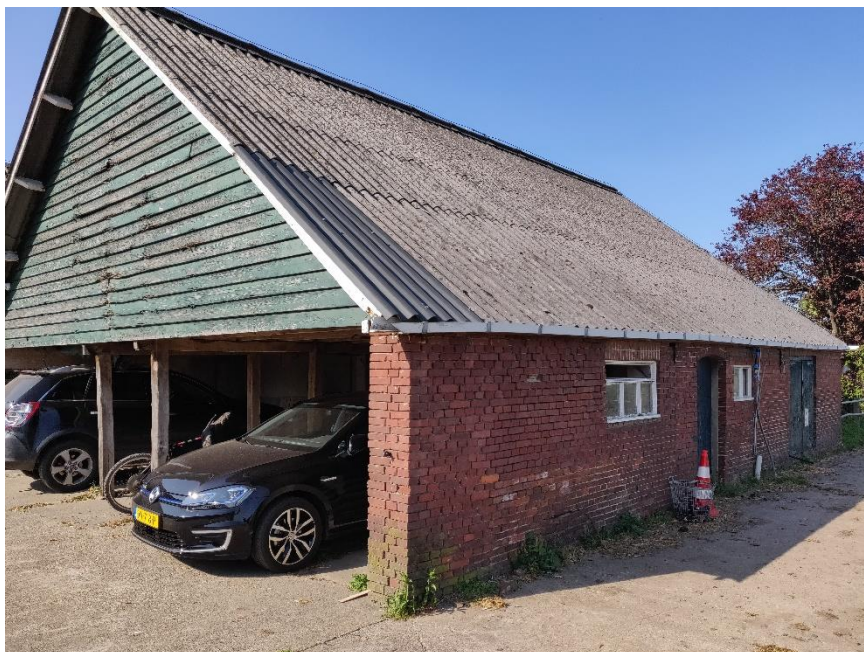
Figuur 1 Te slopen schuur/garage (voorzijde).
