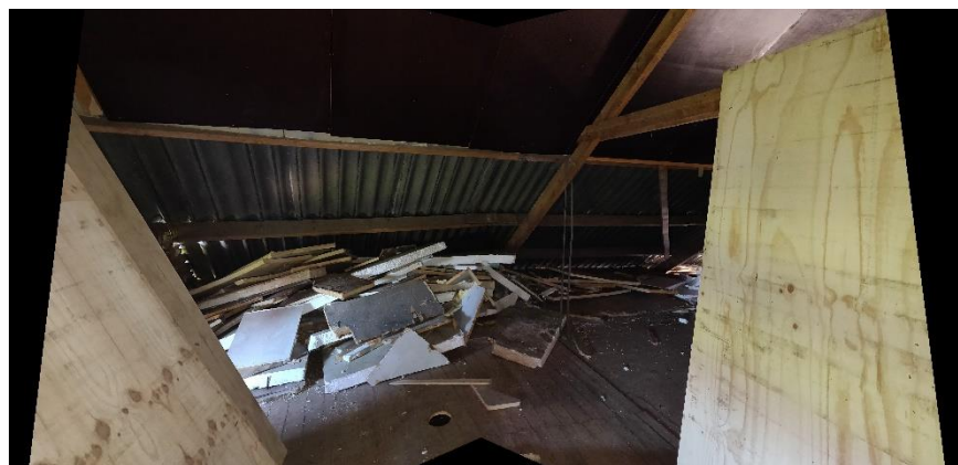
Figuur 4 Zolder met golfplatendak dat deels geïsoleerd is.
