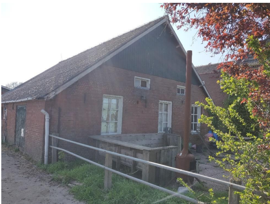
Figuur 2 Te slopen schuur/garage (achterzijde).
