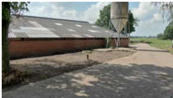
Figuur 16: Onverharde afwateringszone
