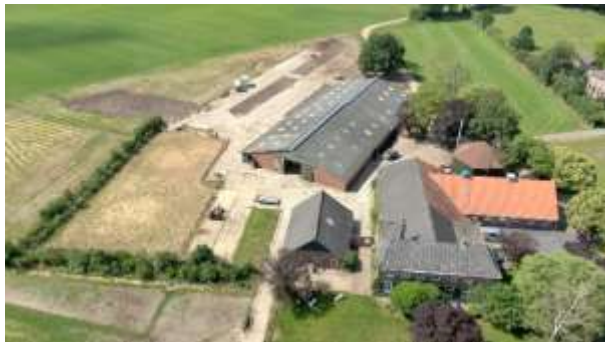
Figuur 15: Overzichtsfoto onderzoekslocatie
