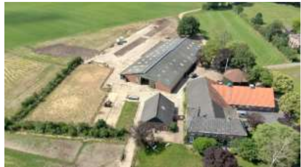
Figuur 2: Overzichtsfoto onderzoekslocatie
