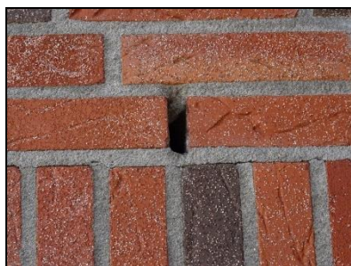
Figuur 13. Brede stootvoeg die toegang verleent tot de spouw.
