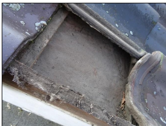
Figuur 10. Beschikbare ruimte onder dakpannen.
