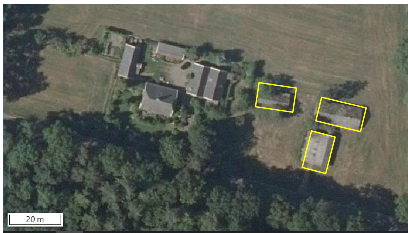
Begrenzing van de te slopen gebouwen; deze wordt met de gele lijn aangeduid (bron luchtfoto: ruimtelijkeplannen.nl).
