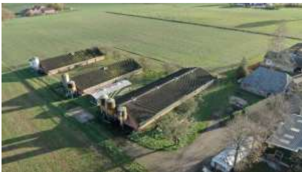
Figuur 15: Aanwezige onverharde afwateringzones
