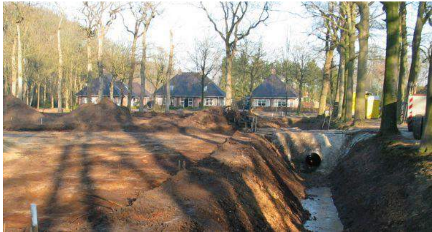
Aanleg van een gracht
