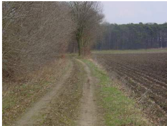
Zandpaden hebben een bol profiel. Om kuilvorming te voorkomen moet het zandbed droog blijven en dus goed afwateren.
