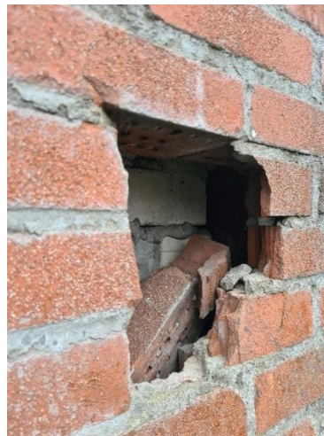
Spouwmuur van loods
