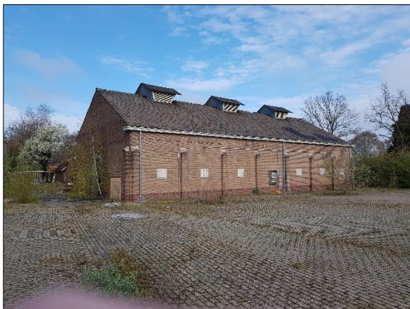
Figuur 7. Gebouw in noorden plangebied
