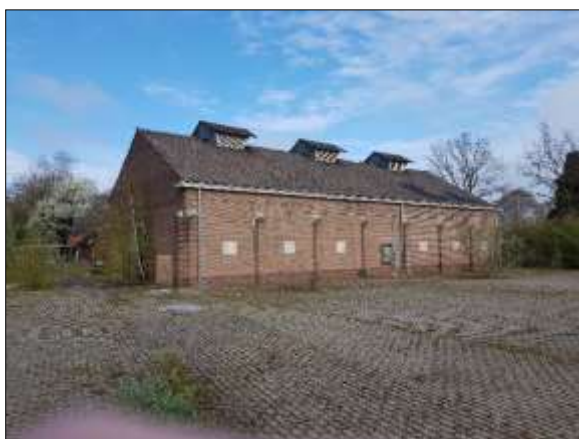
Figuur 8. Gebouw in noorden plangebied
