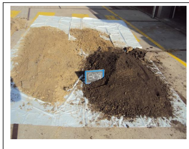
Foto 4. Opgegraven en gezeefd materiaal sleuf B03
