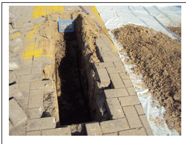
Foto 3. Opgegraven en gezeefd materiaal sleuf B03
