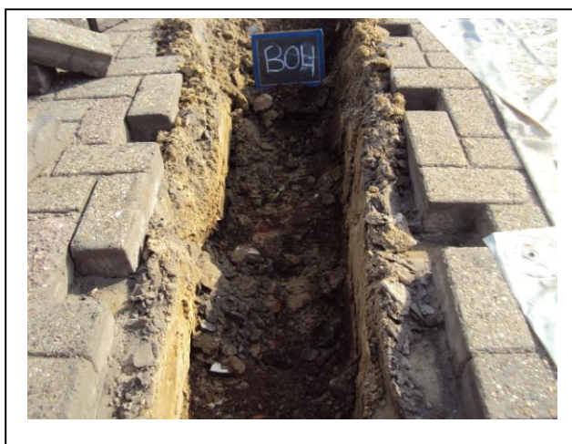
Foto 5. Opgegraven en gezeefd materiaal sleuf B04
