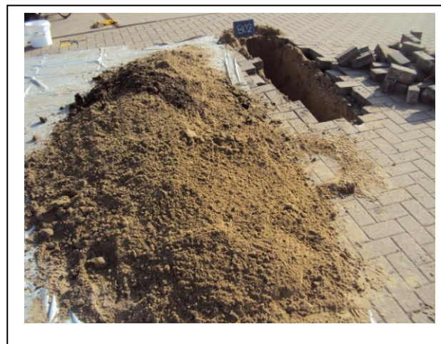
Foto 2. Opgegraven en gezeefd materiaal sleuf B02
