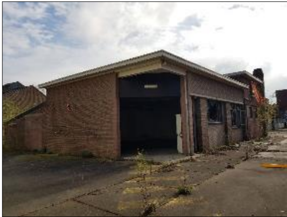
Figuur 5. Gebouw centrale deel plangebied
