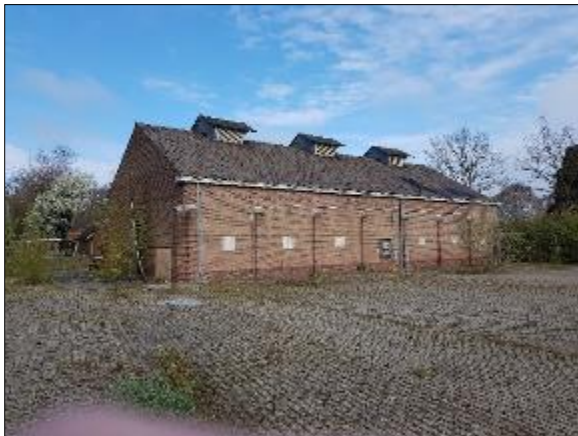
Figuur 7. Gebouw in noorden plangebied
