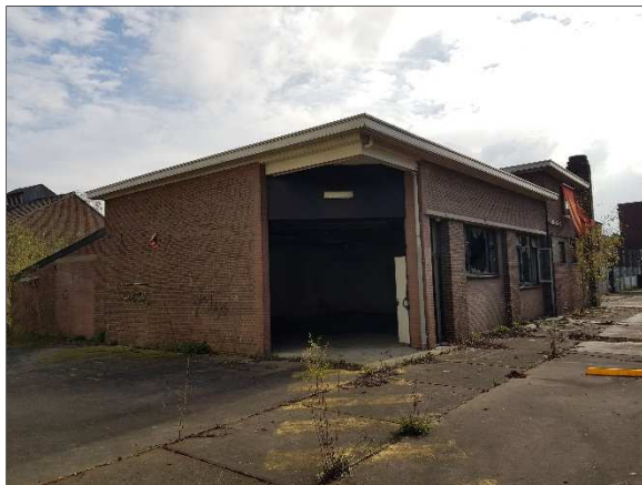
Figuur 6. Gebouw centrale deel plangebied
