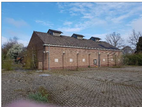
Figuur 8. Gebouw in noorden plangebied
