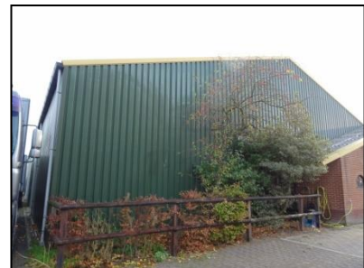
Figuur 14. Enkelwandig en strak afgewerkte paardenhal.
