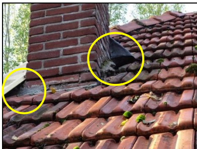
Figuur 12. Betimmering en loodslabben die toegang kunnen verlenen tot potentiële verblijfplaatsen van vleermuizen.
