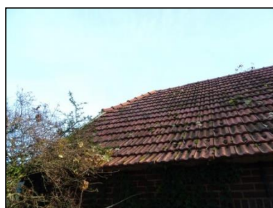
Figuur 7. Zuidzijde van de varkensstal naast het woonhuis.
