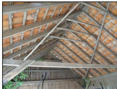
Figuur 13. Het open dak van de karloods.
