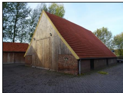
Figuur 4. Schuur op de onderzoekslocatie.
