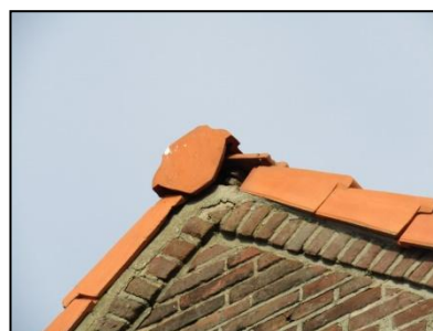
Figuur 8. Detailfoto dakrand.
