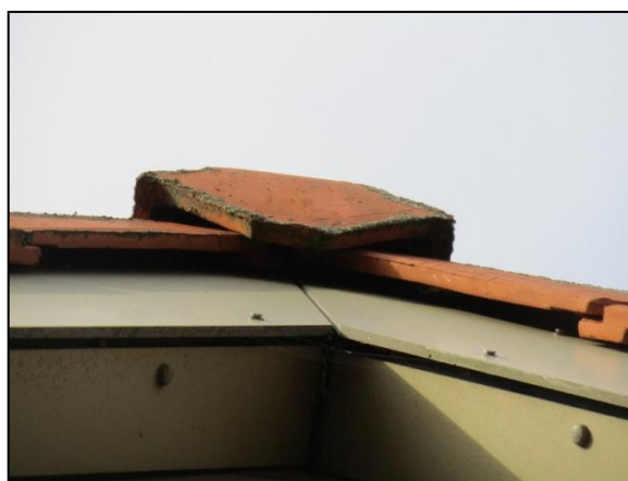
Figuur 10. Ruimte langs de dakranden geeft toegang tot de ruimte onder het dak.
