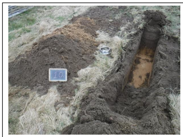
Foto: Inspectiesleuf A10
