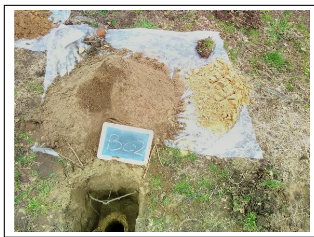
Foto: Inspectiegat B02
