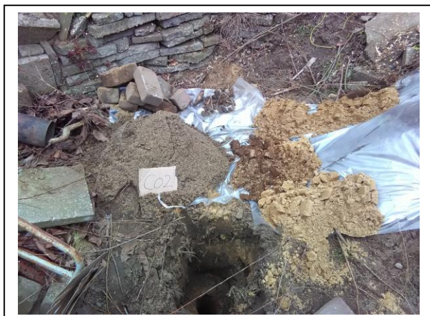
Foto: Inspectiegat C02
