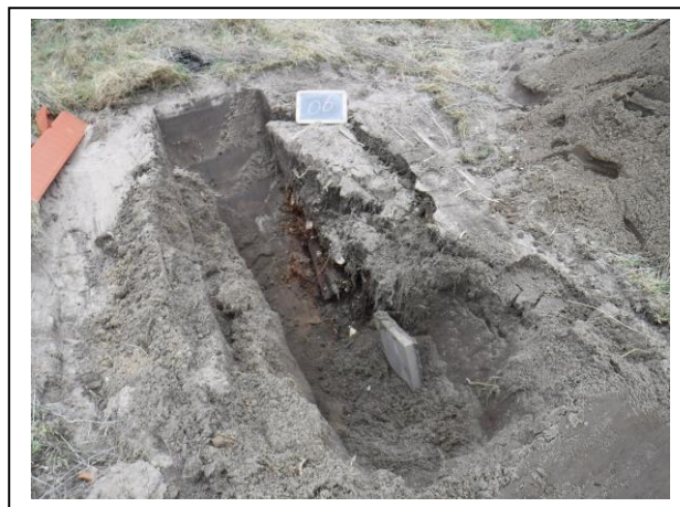
Foto: Inspectiesleuf A06
