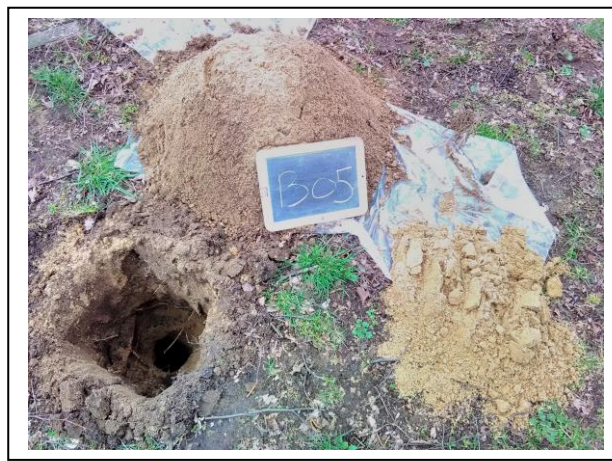
Foto: Inspectiegat B05
