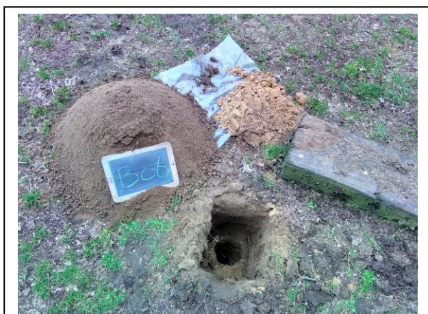
Foto: Inspectiegat B06
