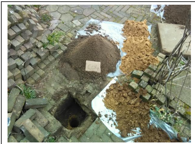
Foto: Inspectiegat C04
