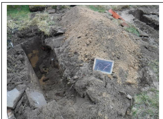
Foto: Inspectiesleuf A07
