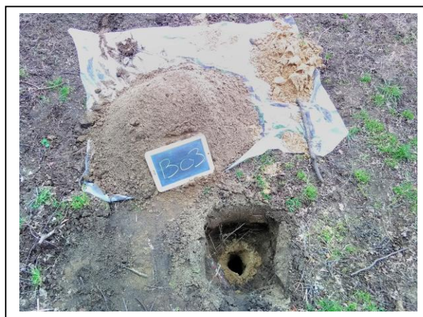
Foto: Inspectiegat B03
