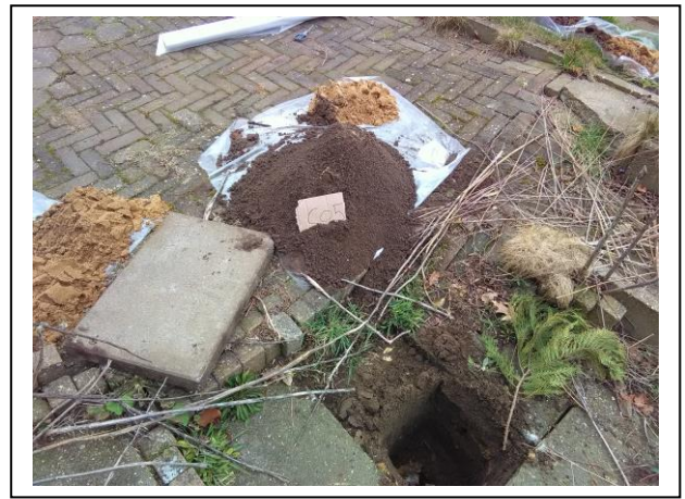
Foto: Inspectiegat C05
