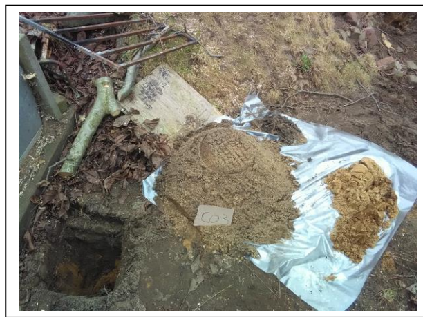
Foto: Inspectiegat C03
