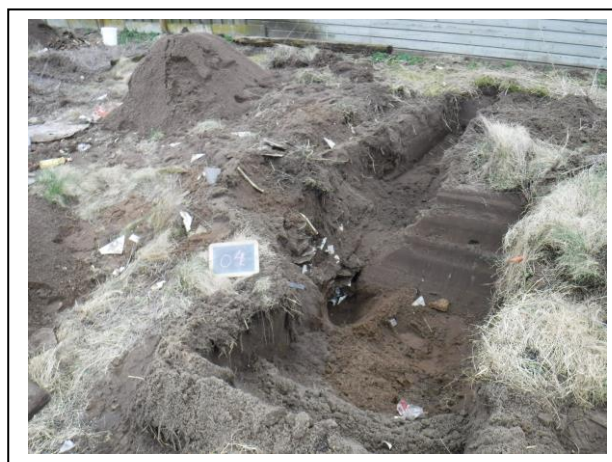
Foto: Inspectiesleuf A04
