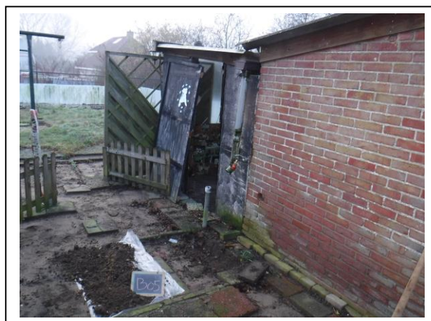
Foto: Inspectiesleuf B05
