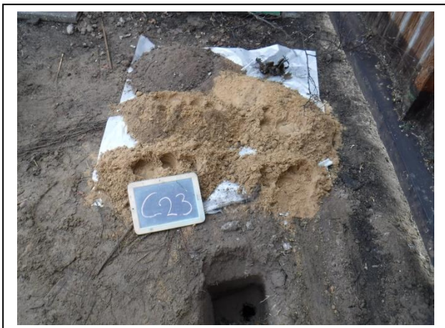
Foto: Inspectiegat C23
