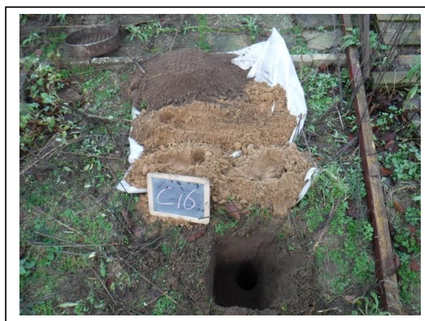
Foto: Inspectiegat C16
