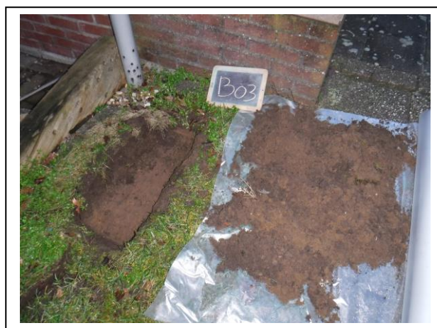
Foto: Inspectiesleuf B03
