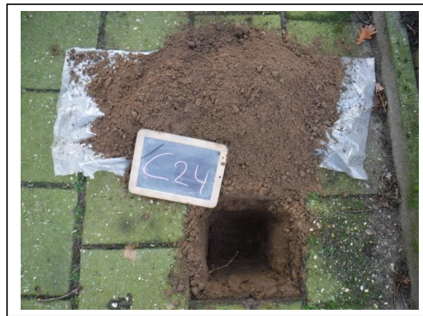
Foto: Inspectiegat C24
