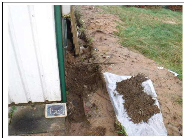
Foto: Inspectiesleuf B09
