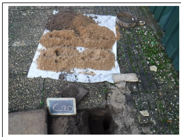
Foto: Inspectiegat C20
