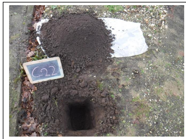
Foto: Inspectiegat C22
