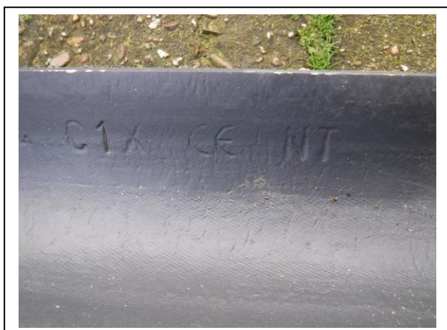
Foto: Inspectiesleuf B01/B02 (asbestvrije golfplaat)
