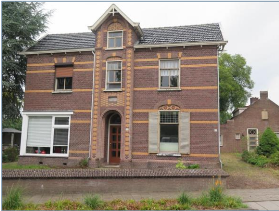
Foto 3. Voorzijde woonhuis op het perceel Prins Bernhardstraat 47-49 met dakgoot en pannendak.
