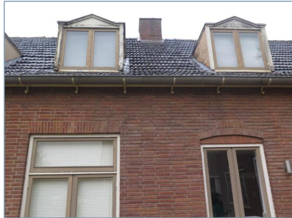
Foto 4. Oostzijde bedrijfsbebouwing op het perceel Prins Bernhardstraat 47-49 met dakgoot en pannendak.
