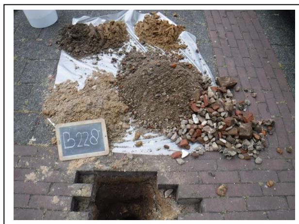
Foto: Inspectiegat B228
