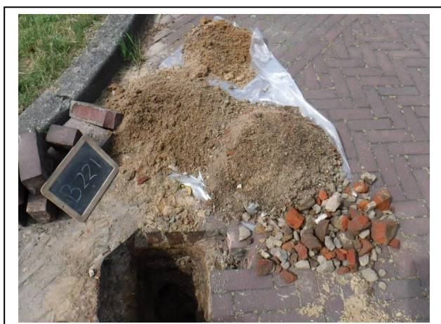
Foto: Inspectiegat B221
