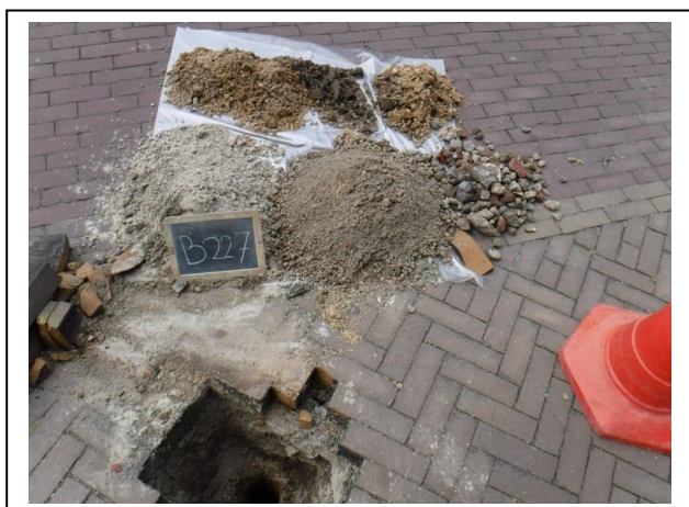
Foto: Inspectiegat B227
