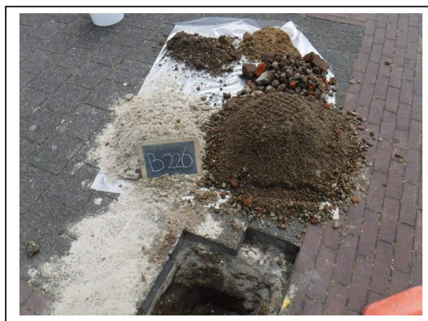
Foto: Inspectiegat B226
