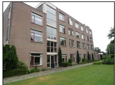
Figuur 8. Zuidzijde woonzorgcentrum.
