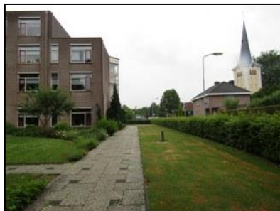
Figuur 7. Zuidzijde onderzoekslocatie.
