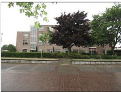
Figuur 3. Oostzijde onderzoekslocatie.
