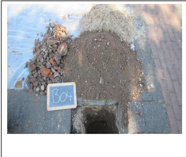
Foto: Inspectiegat B04
