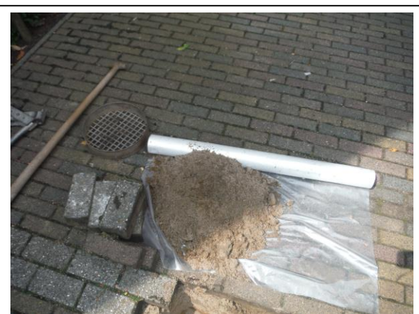
Foto: Inspectiegat A06
