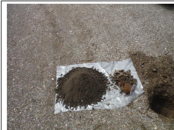
Foto: Inspectiegat A01
