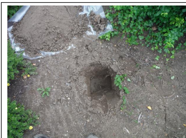
Foto: Inspectiegat A05
