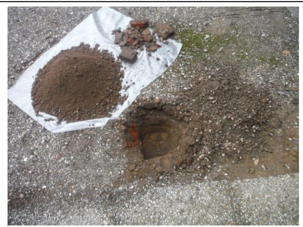
Foto: Inspectiegat A02
