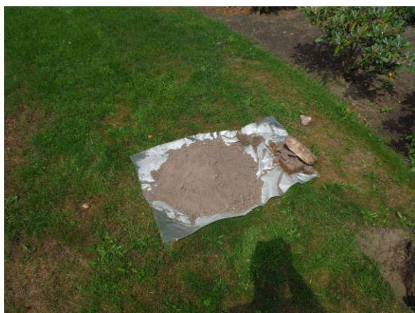
Foto: Inspectiegat A09
