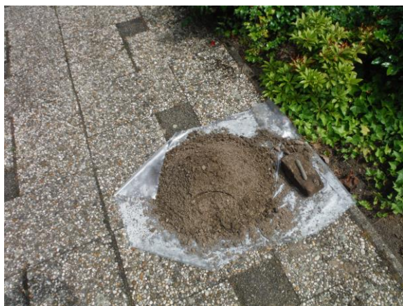
Foto: Inspectiegat A08
