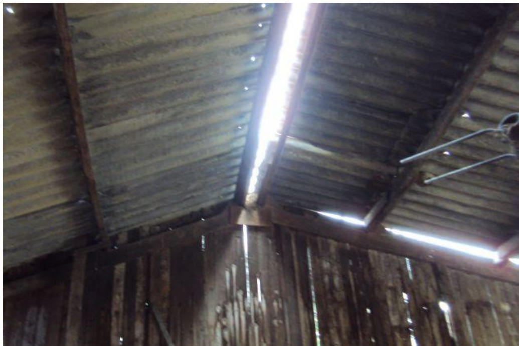
Foto 4. De schuren zijn niet geschikt voor vleermuizen (binnenzijde werktuigberging).
