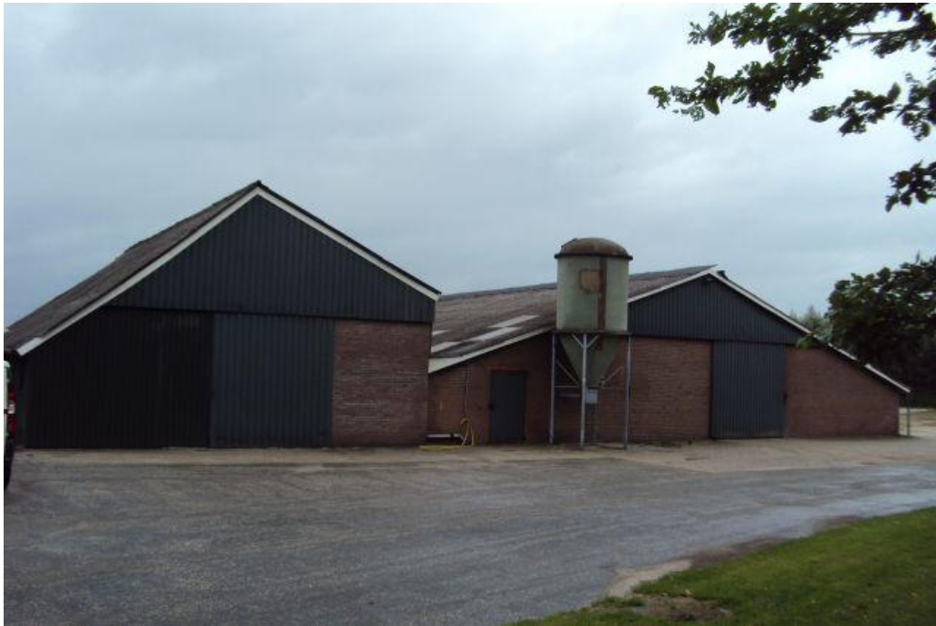
Foto 1. Te slopen rundveestal (rechts) en berging, middendeel onderzoekslocatie.
