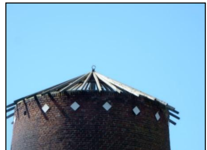
Figuur 8. Detail dak molen.
