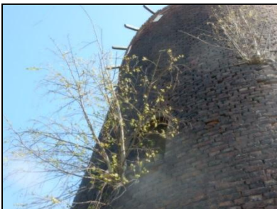
Figuur 6. Detail muurdelen molen met begroeiing.
