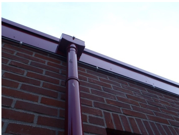
Foto 5: detail van het boeiboord van de videotheek. Let op de goede staat van onderhoud waarmee dit boeiboord tegen de gevel aan zit. Bovendien loopt hier nog een elektraleiding die een eventuele spleet nog een keer afdekt.
