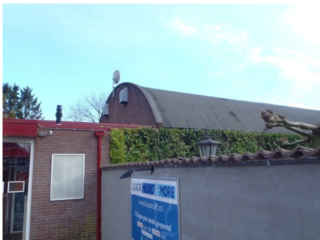
Foto 4: de hoek van de videotheek met daarachter de filmzaal. Duidelijk zichtbaar is de bitumen dakbedekking van de filmzaal die de muur aan de bovenzijde compleet afdekt. Op de kopgevel zijn de beide ontluuchtingsroosters zichtbaar.
